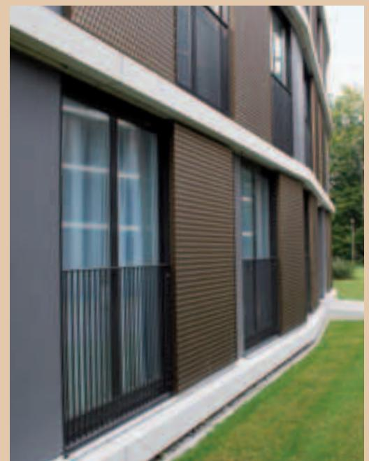
Les brise-soleil coulissants peuvent être positionnés à souhait et garantissent un confort visuel et thermique optimal.
