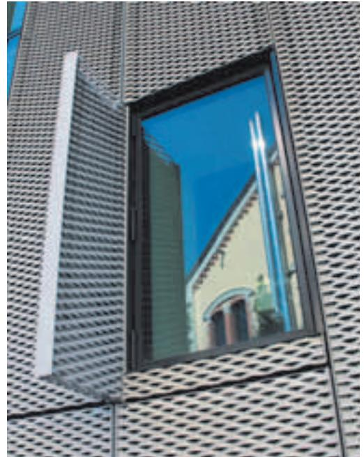
Enveloppe verticale du bâtiment, faux-plafonds horizontaux, "nageoires" latérales comme des lames aux ouvertures de fenêtres pour un double objectif: habillage et ombrage.
