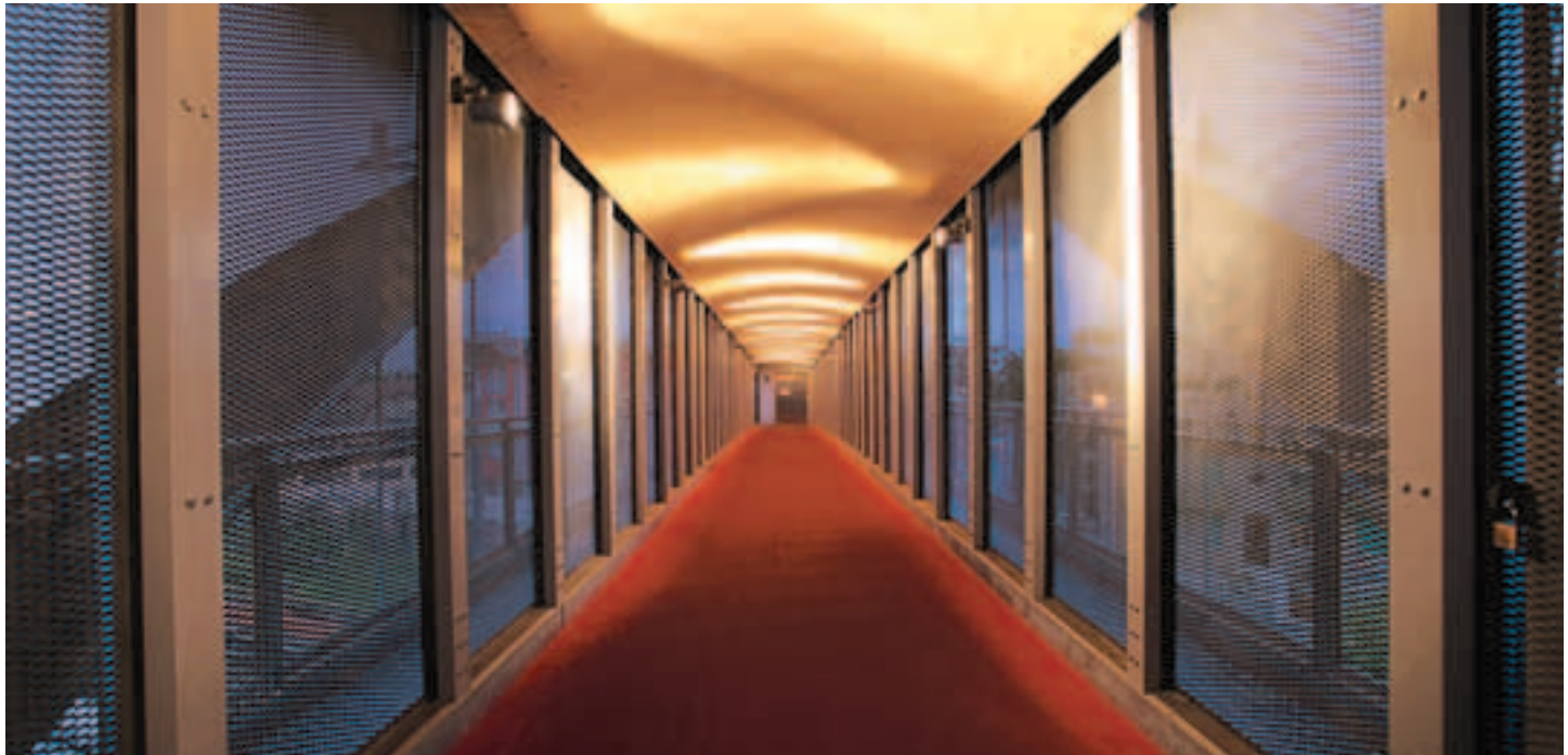
Maglia/Mesh: Parapetto corridoio FILS 5 62,5 x 20 - 7,5 x 3 mm (Pag. 88) Acciaio al carbonio Sendzimir verniciato Powder coated pre-galvanized steel Parapetto scale esterne TIPO 43 43 x 10 - 3 x 3 mm Acciaio al carbonio zincato a caldo Hot dip galvanized steel
