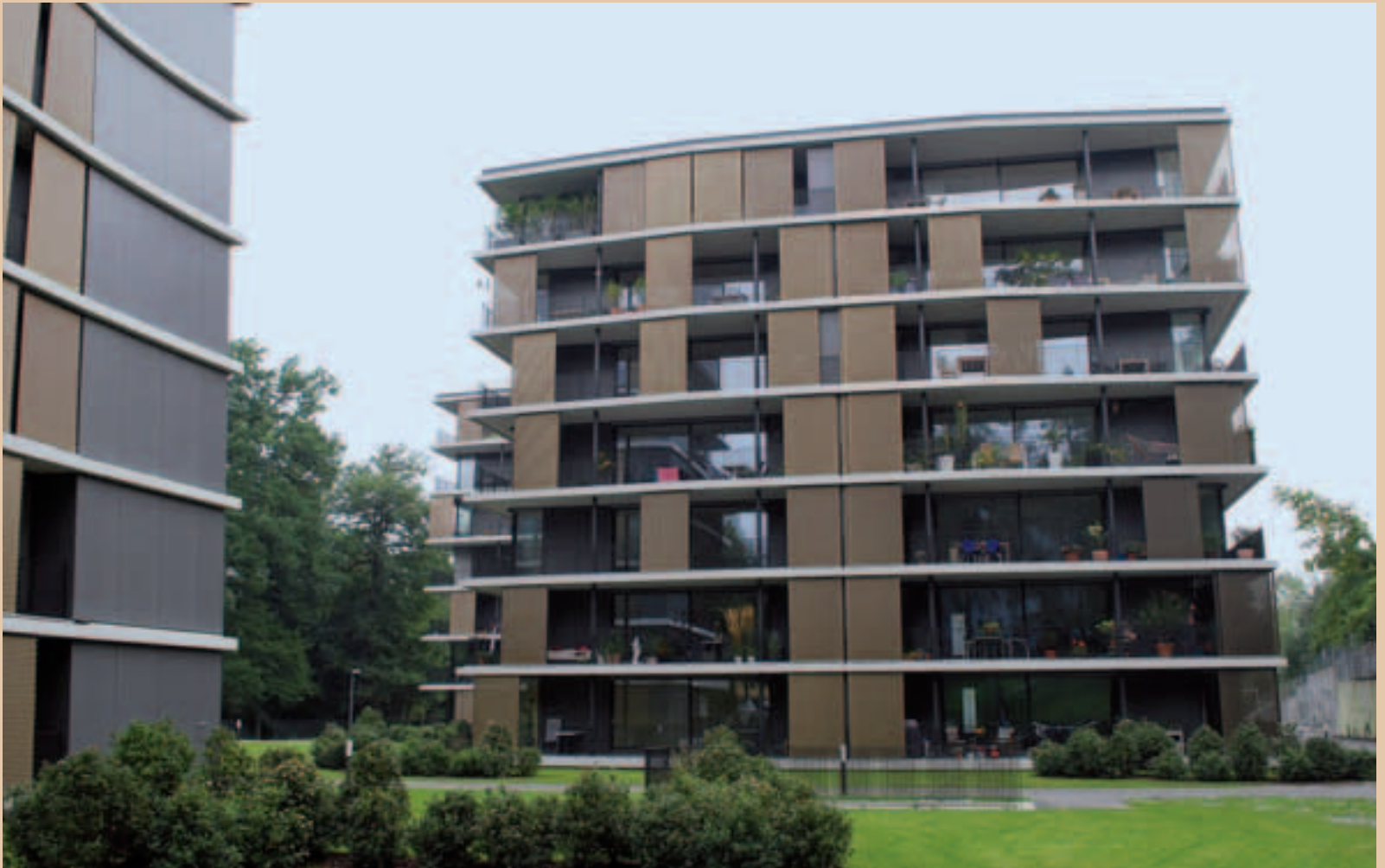
WOHNÜBERBAUUNG ROTSEEPARK - LUZERNE (Switzerland) Design: Rigert + Bisang Architekten Photo: © André Huber
