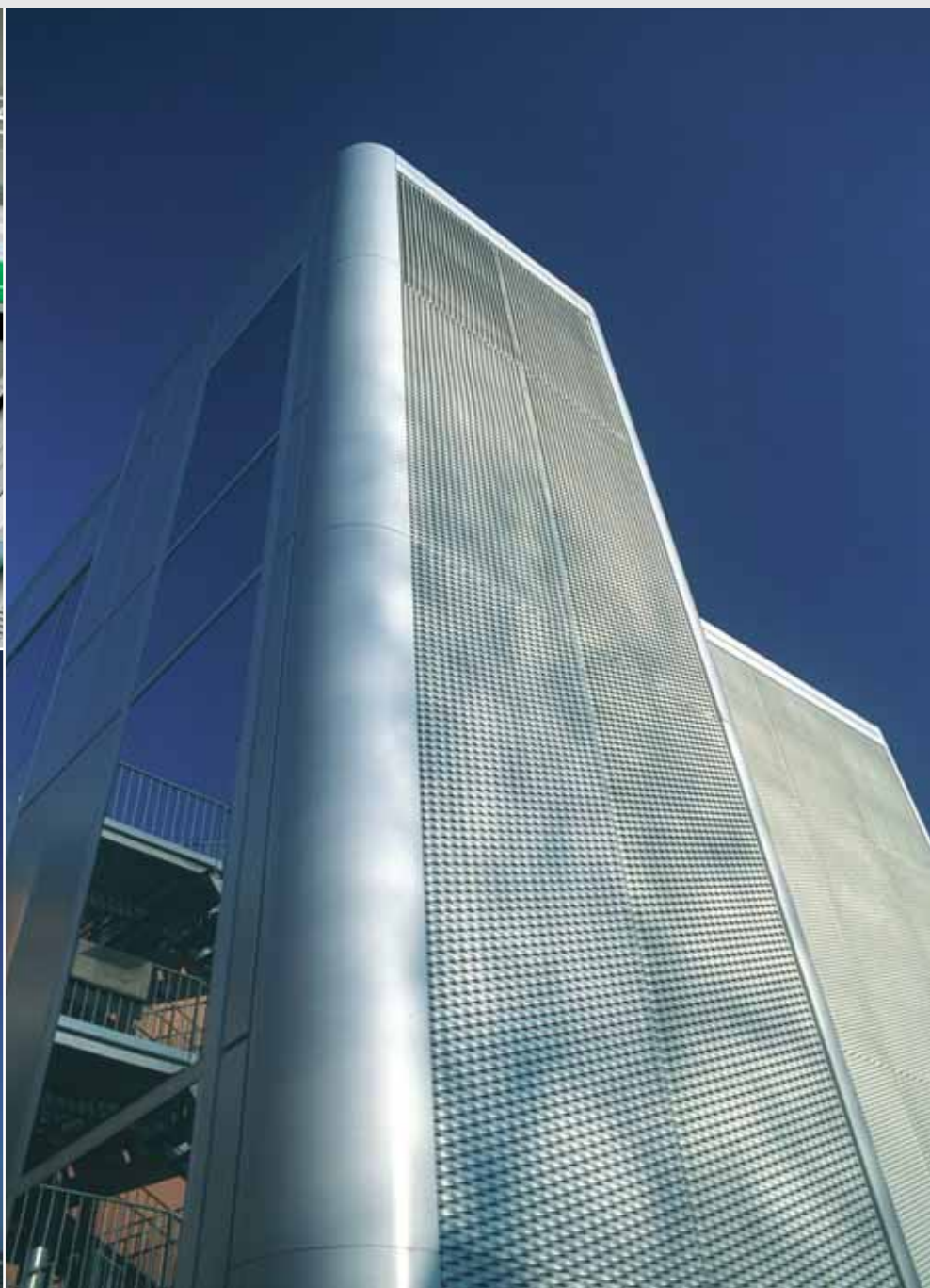
RESERVE - DL 90 x DC 30 (38) - av 18 x sp 1,5 mm Aluminio anodizado natural
