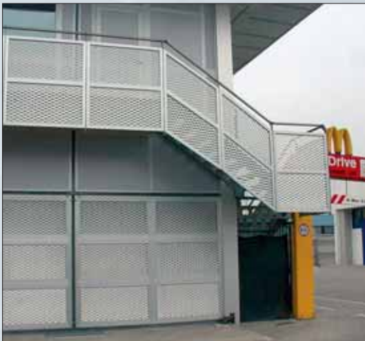
AMBASCIATA - DL 110 x DC 40 (52) - av 24 x sp 1,5 mm Aluminio anodizado natural
