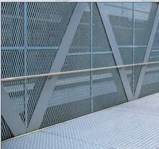
SP 2 - DL 110 x DC 40 (41,6) - av 9,5 x sp 4 mm Hierro galvanizado en caliente
