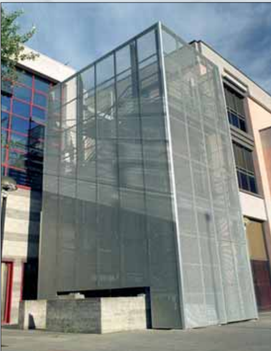
AIRPORT - DL 62,5 x DC 20 (25,5) - av 9,1 x sp 1,5 mm Aluminio anodizado natural
