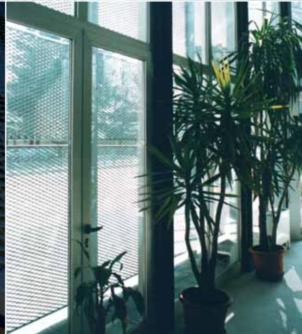
GATE - DL 76 x DC 31 (35) - av 11 x sp 2 mm Hierro galvanizado en caliente
