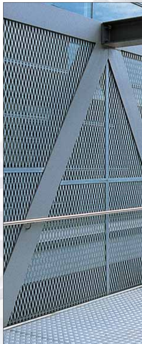
SP 2 - LD 110 x CD 40 (41,6) - l 9,5 x e 4 mm Acier galvanisé à chaud
