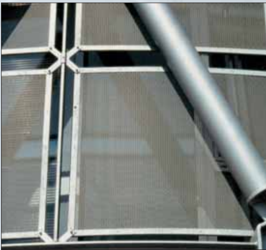
TYPE 25 - LD 28 x CD 10 (10) - l 1,5 - e 1,5 mm Acier thermolaqué par poudrage polyester pour l'extérieur
