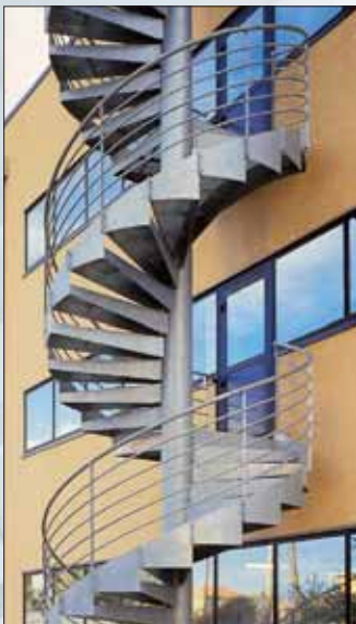
Marches balancées et paliers en acier galvanisé à chaud
