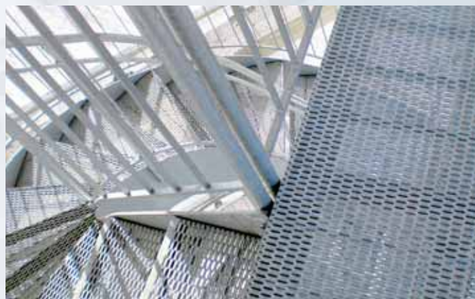
Marches et paliers en acier galvanisé à chaud
