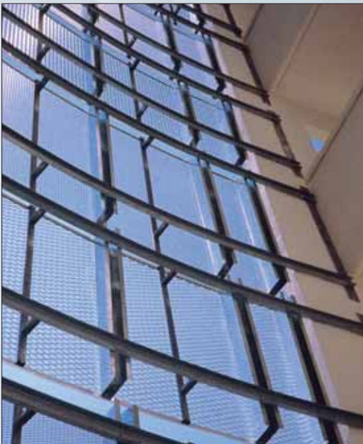
FILS 21 - LD 45 x CD 15 (13,4) - l 5 x e 1,5 mm GATE - LD 76 x CD 31 (35) - l 11 x e 1,5 mm Aluminium anodisé naturel
